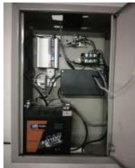
Gambar 4. Rangkaian PLTS 500 Watt
